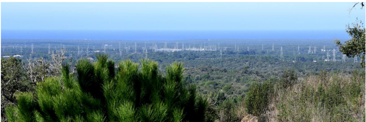
Figura 11 - Aspeto da zona envolvente à subestação de Sines a partir da zona sul da serra de Grândola, percebendo-se a elevada densidade de apoios de linha existentes na aproximação à subestação.
